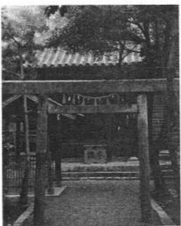
旧桑名城本丸鎮座 桑名招魂社 本殿入母屋瓦葺 5.55坪 拝殿入母屋瓦葺 19.25坪
