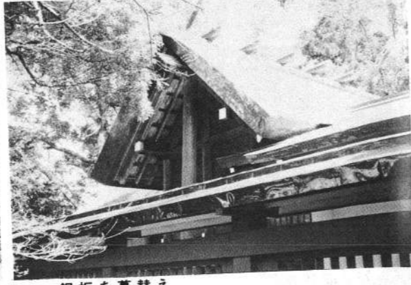
銅板を葺替え
